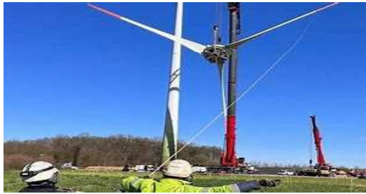
風力発電施設の建設
